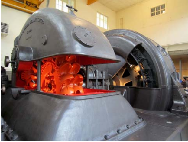
Рисунок 8.4 – Ковшовая гидротурбина 1918 г. выпуска производства Theodor Bell & C ie ( a ) и генератор 12000 кВт, 8 – 8,5 кВ производства Brown, Boveri & C ie ( б )
