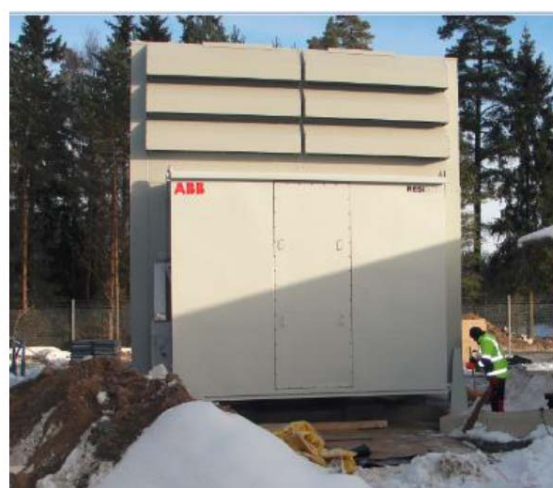
Рисунок 4.4 – Сухой трансформатор 45 кВ, 16 МВА для наружной установки
