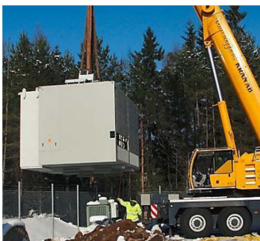
Рисунок 4.4 – Сухой трансформатор 45 кВ, 16 МВА для наружной установки
