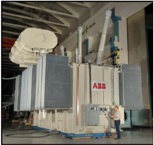
Рисунок 3.1 – Управляемый шунтирующий реактор 120-200 Мвар, 420 кВ, используемый в электрических сетях Норвегии
